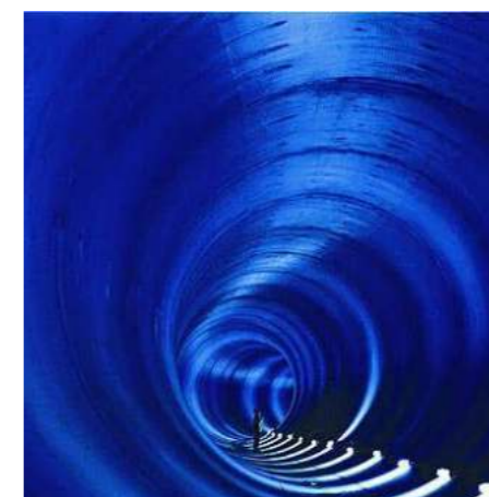
Planta de DPR de Changi en Singapur.
