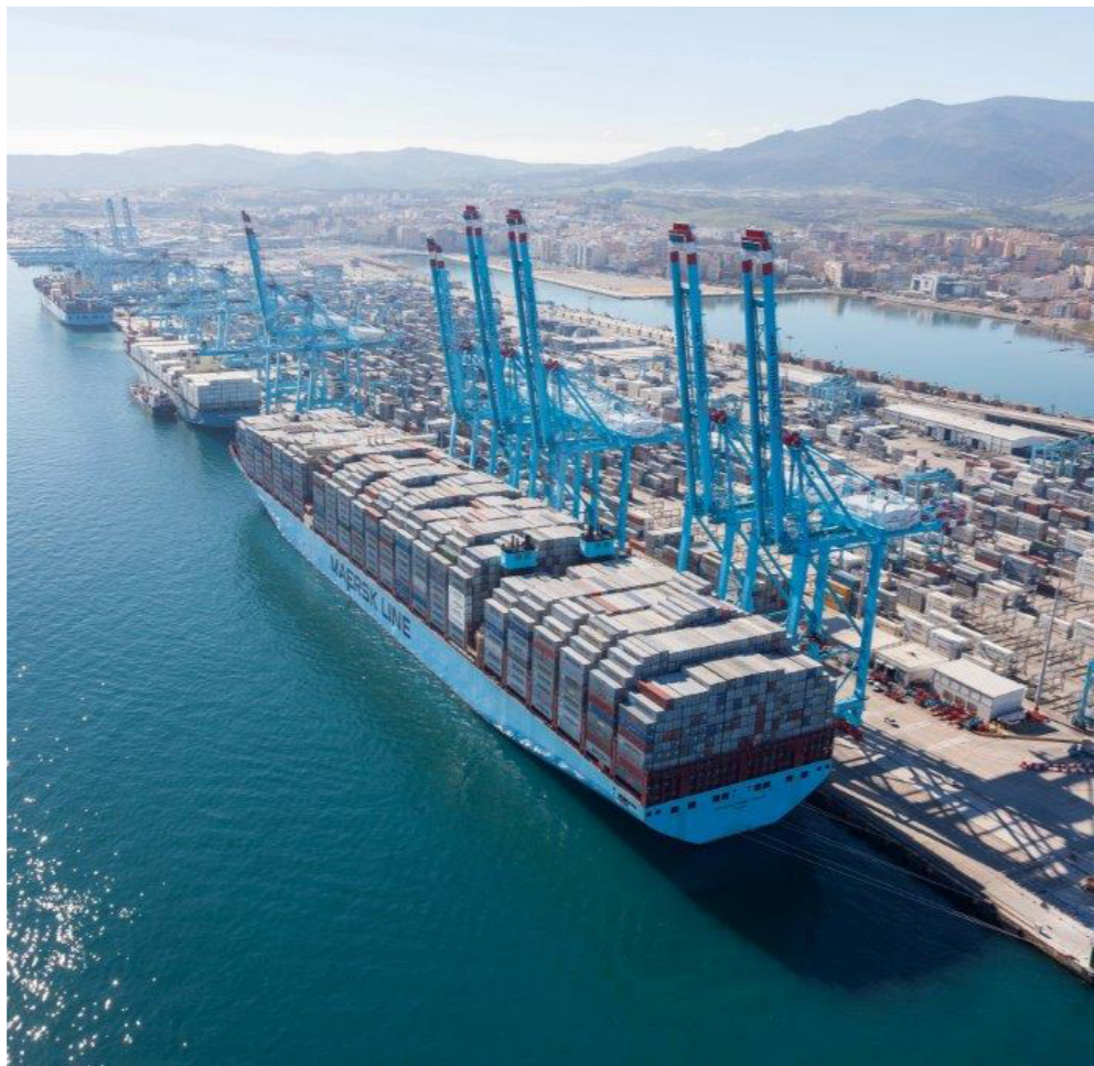
Vista aérea del Puerto de Algeciras.
