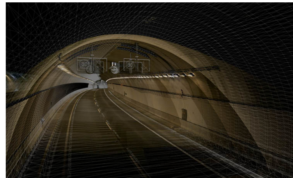
Interior de uno de los túneles en los que ha trabajado Fulcrum. / FULCRUM
