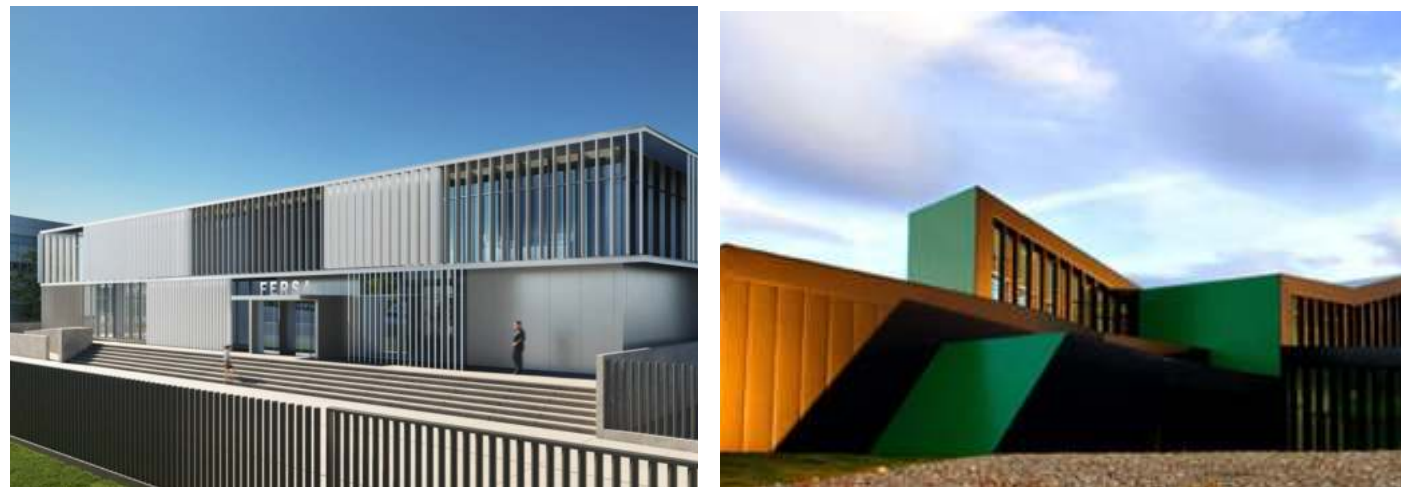
Edificios de Fersa Lab e Itainnova, que actuarán como sede del próximo Collaborate Zaragoza 2024. / INGENUUS / ITAINNOVA
