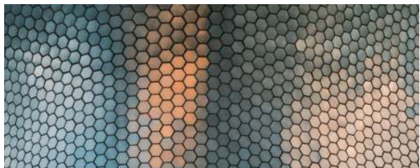
NUEVAS FACHADAS Y AUTOMATIZAR LA ENTREGA DE AGV
