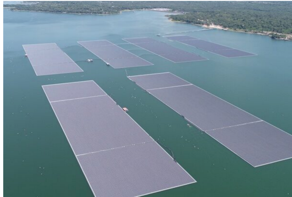
Energía hidroeléctrica híbrida solar flotante en la presa de Sirindhorn en Tailandia.
