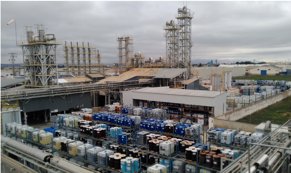
Vista aérea de la planta murciana de Takasago International Chemical.
