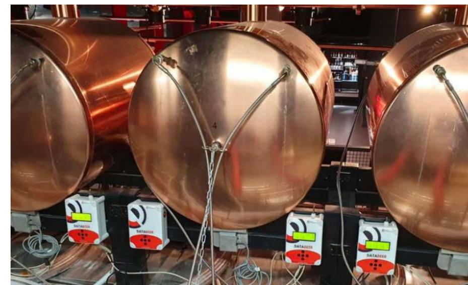
Sistema de Data Monitoring en tanques de cerveza.
